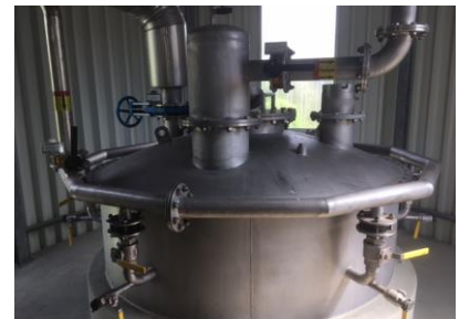
Bewerten eines Faulbehälters durch die Fa. WHS
